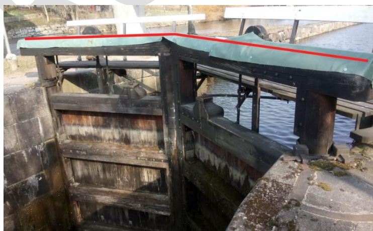
Figur D.2.1d. Slussport mäts genom slussportarna i stängt läge.
