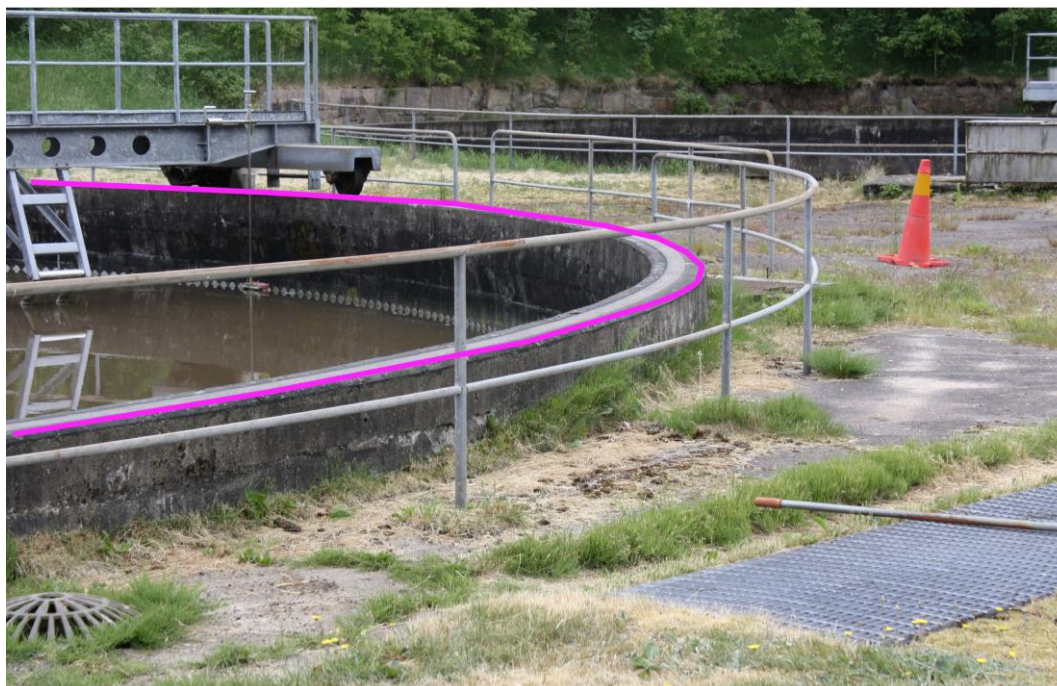
Figur 4.3d Exempel på plan- och höjdläge för bassängkant. Om ytbildning och kodning av ytan önskas sätts centroid (avsnitt 6.1.2) och kod sätts till bassäng (nivå 4 av marktäcke, dvs vatten/stillastående vatten, anlagt stillastående vatten/bassäng)
