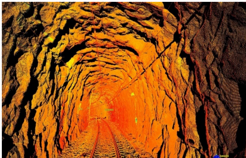
Figur 4.1.e. Tunnel dokumenterad med terrester laserskanning.
