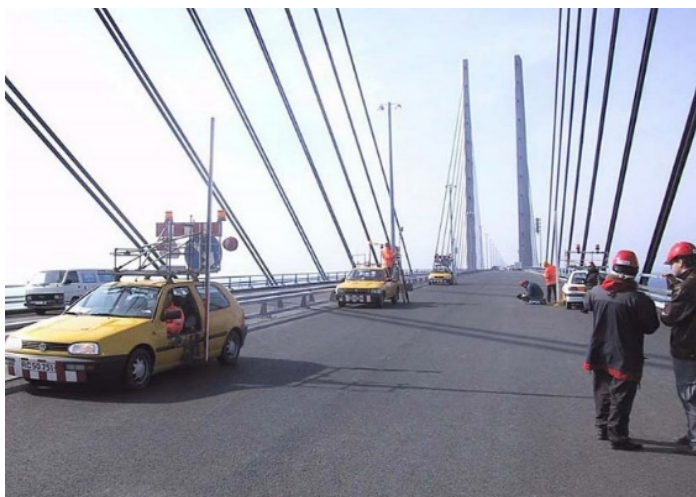
Figur 4.1.b. Höjdmätning av ett långsträckt objekt: motoriserad avvägning på den 7845 meter långa Öresundsbron.
