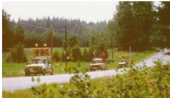
Figur 2. Motoriserat avvägningslag i arbete.
