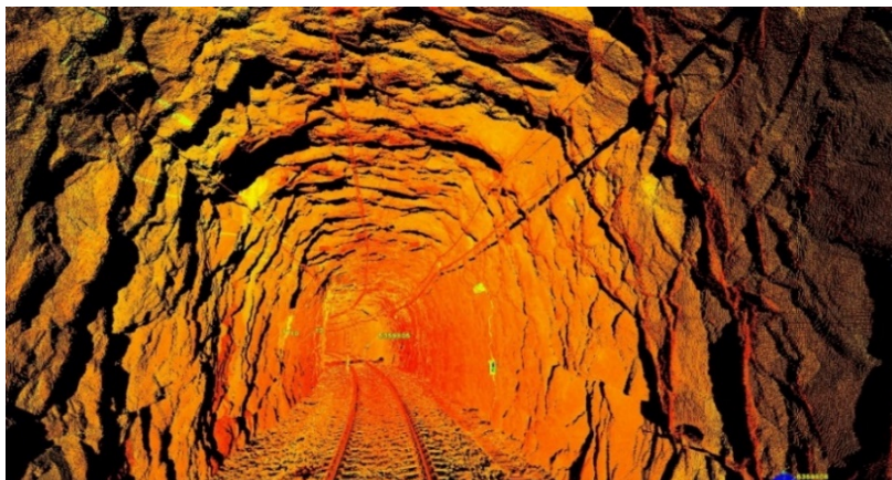
Figur D.7.b. Dokumentation av en tunnel med terrester laserskanning.
