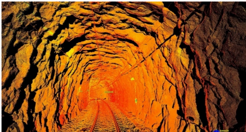
Figur 13. Dokumentation av en tunnel med terrester laserskanning.
