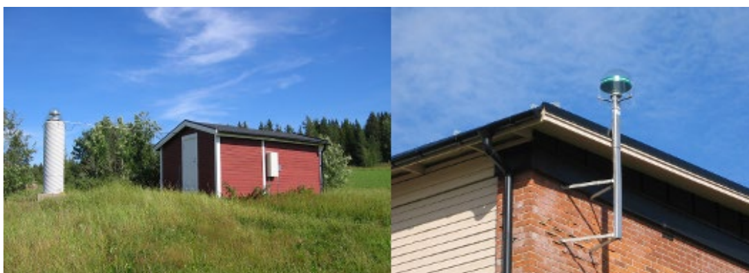
Figur 3.3.1.a. Exempel på fasta referensstationer i SWEPOS-nätet, klass A (vänster) respektive klass B (höger).
